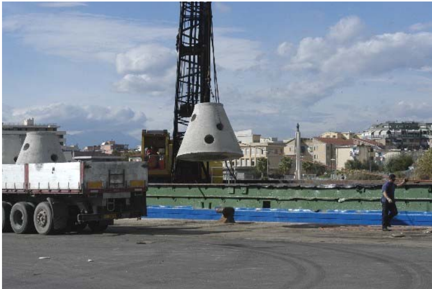
Fig. 22. Una campana in calcestruzzo caricata sul pontone.
