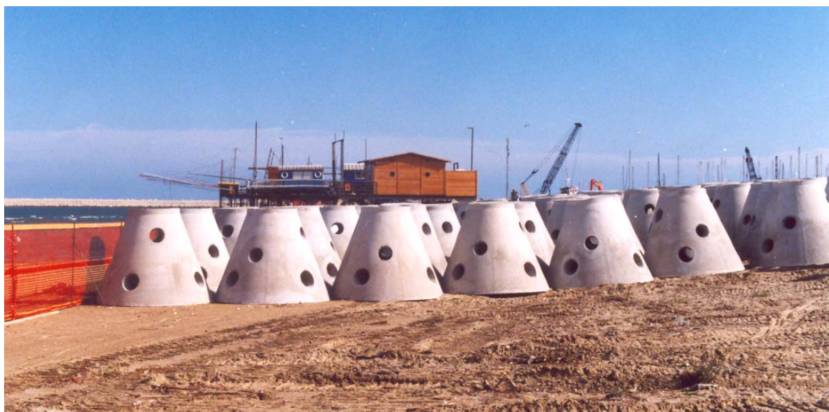
Fig. 20. Campane in calcestruzzo depositate sulla spiaggia di Pescara prima di essere caricate sul pontone.
