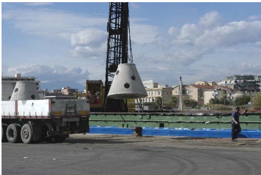
Fig. 21. Una campana in calcestruzzo caricata sul pontone.
