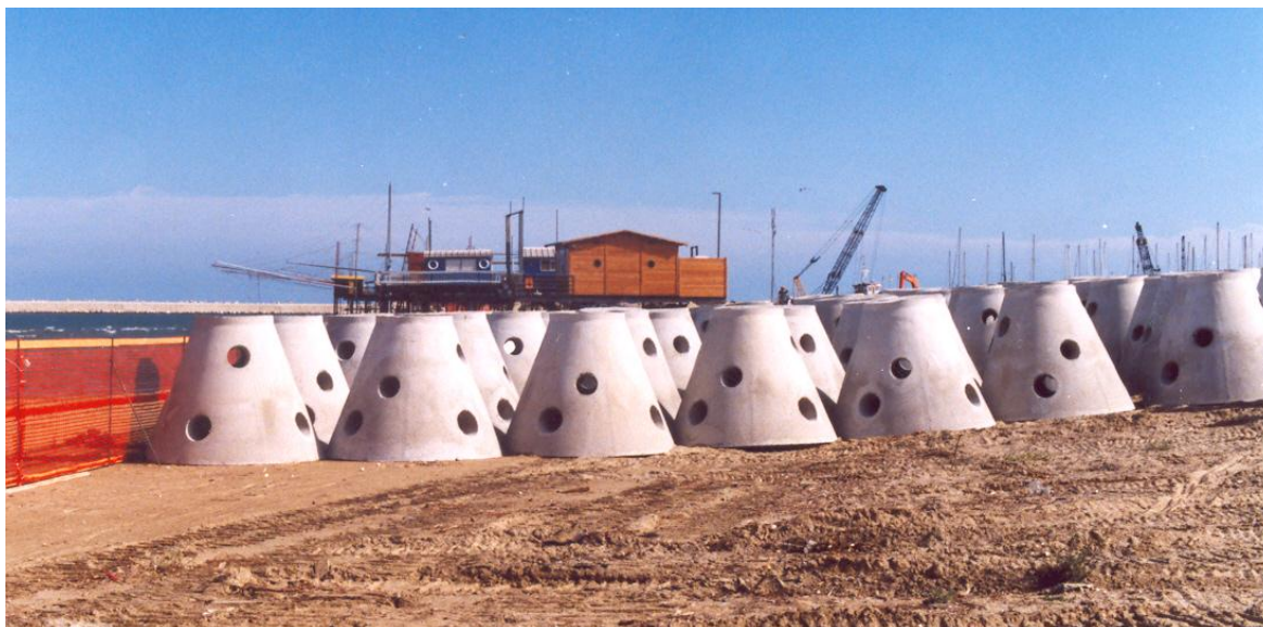
Figura 21. Campane in calcestruzzo depositate sulla spiaggia di Pescara prima di essere caricate sul pontone.
