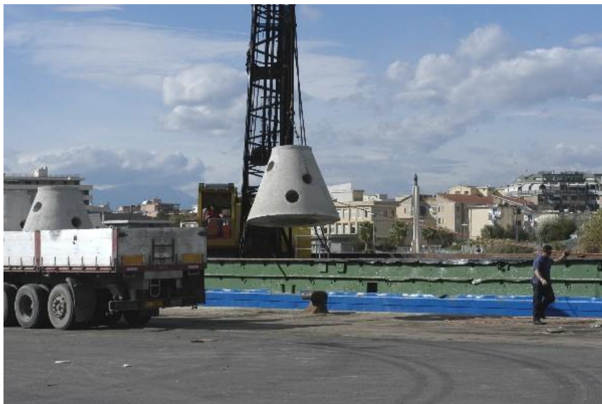
Figura 22. Una campana in calcestruzzo caricata sul pontone.
