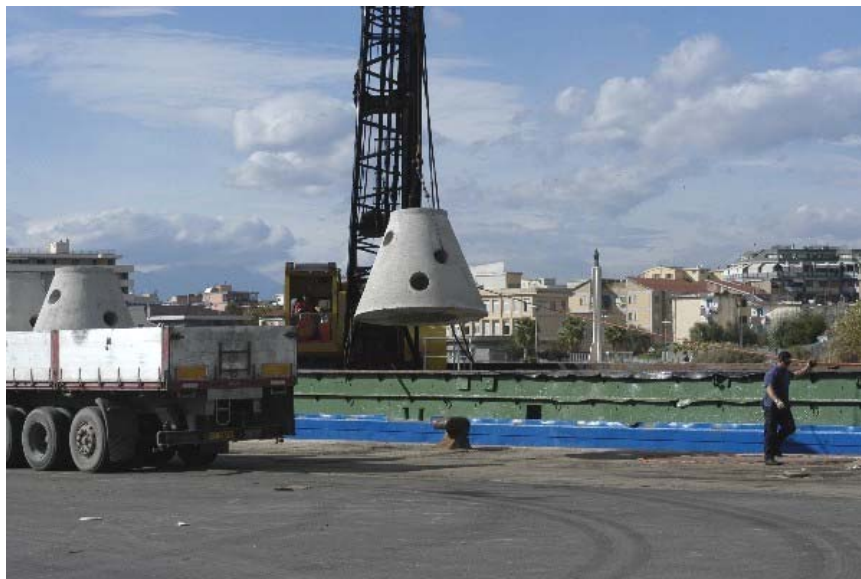
Fig. 22. Una campana in calcestruzzo caricata sul pontone.
