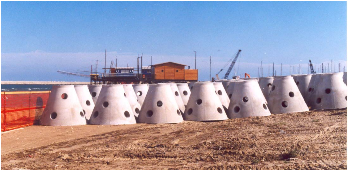
Fig. 21. Campane in calcestruzzo depositate sulla spiaggia di Pescara prima di essere caricate sul pontone.
