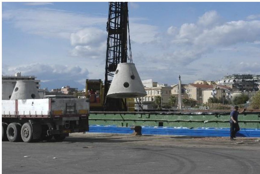
Fig. 22. Una campana in calcestruzzo caricata sul pontone.
