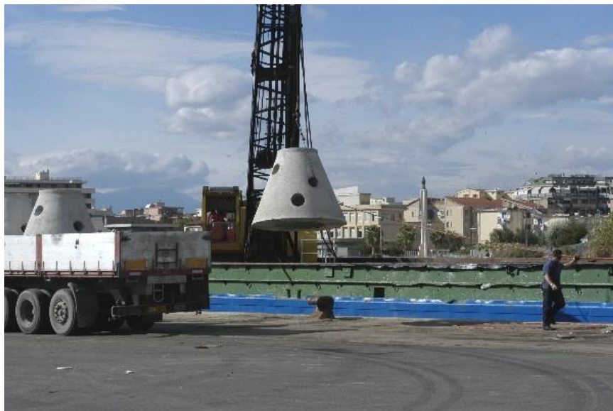
Fig. 22. Una campana in calcestruzzo caricata sul pontone.
